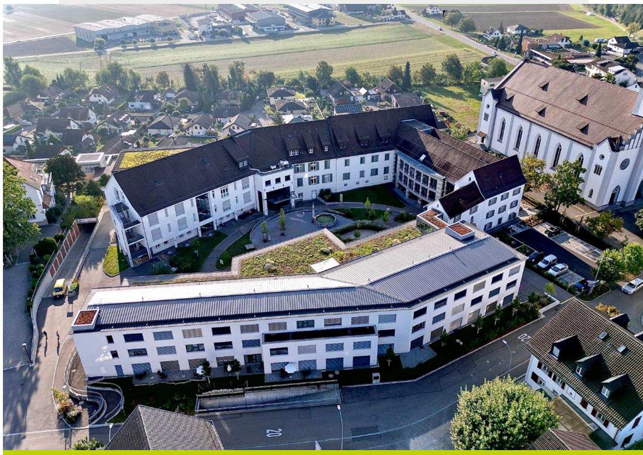
Aus der Luft Das Spital eingebettet mit dem Pflegeheim- Neubau im Vordengrund.
